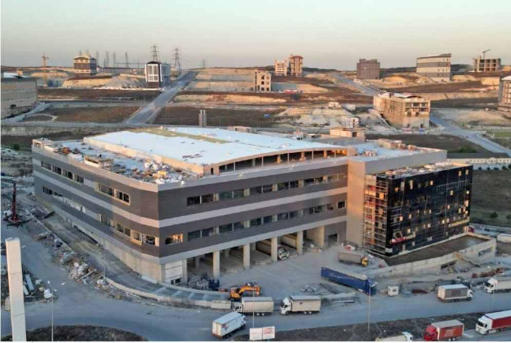
Modern Karton Hadımköy tesislerinin yapımı sürüyor
